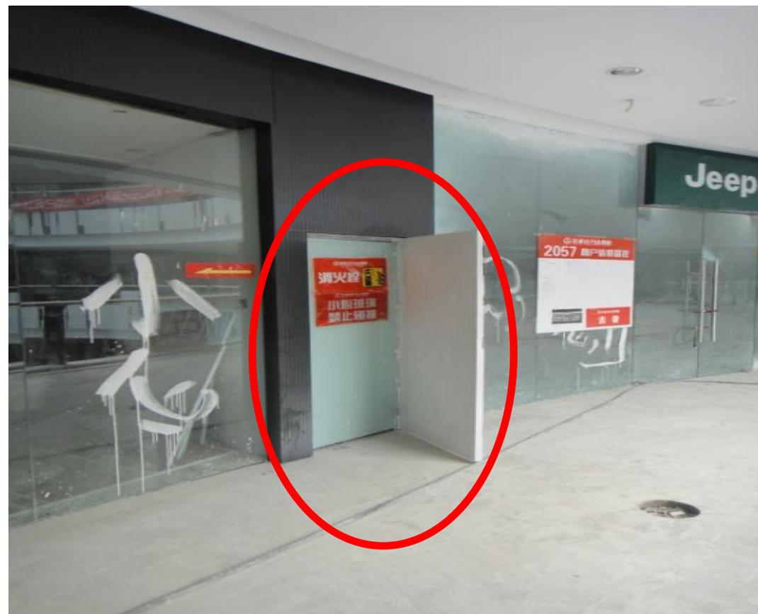
商户在做隐藏式消火栓时破坏内部防火封堵并出现两道门现象
