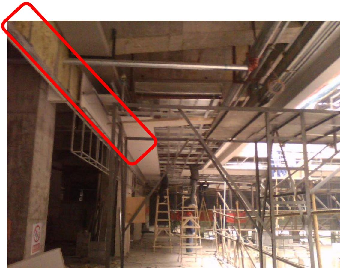
步行街商铺玻璃隔断上方防火封堵必须到位
