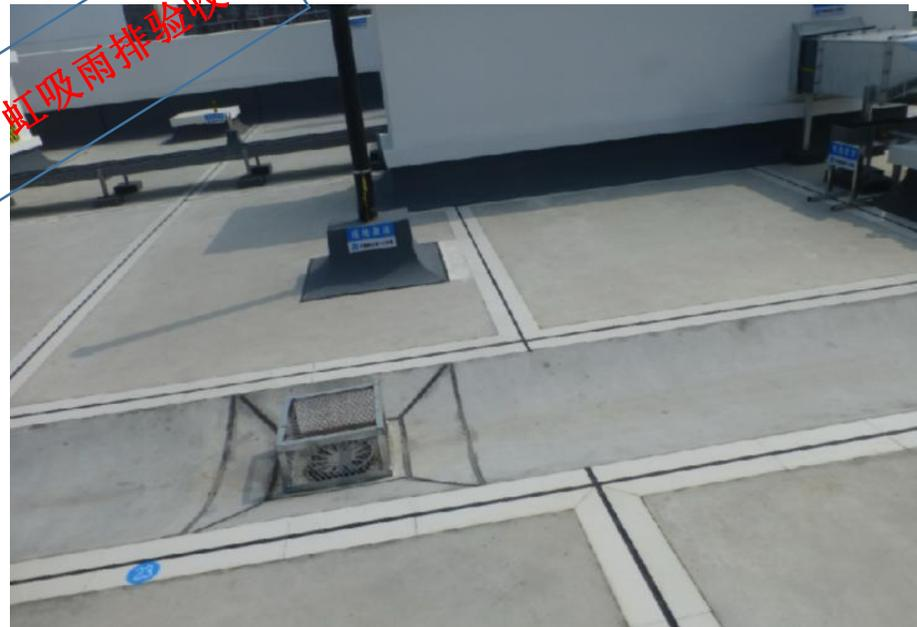
屋面、天沟和虹吸雨水斗内应清理干净，不得留有任何杂物；溢流口或溢流管道系统的设置和施工应符合设计要求；**雨水斗周围屋面渗漏检查结合屋面蓄水或淋水试验进行；雨水立管及水平干管均应做通水试验**，排水应畅通无堵塞；**室内雨水管道根据管材和建筑高度选择整段或分段进行灌水试验**，灌水高度应达到每根立管上部雨水斗口，持续1h，观察管道及连接处渗漏情况
