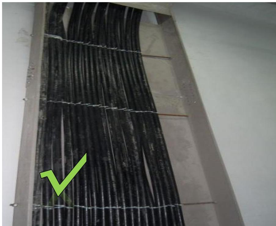
正确做法：电力电缆总截面面积不应大于桥架内截面面积的40%
