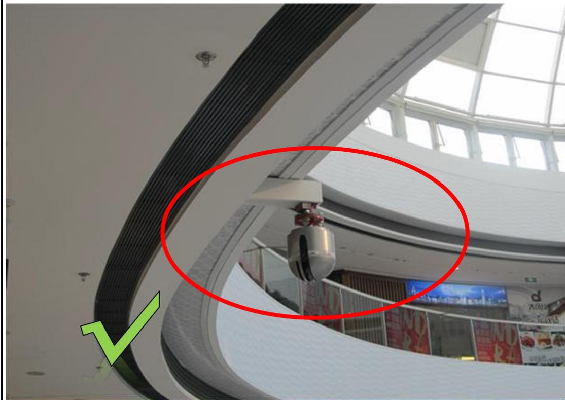
正确做法：短立管设防晃支架；水炮的配套线束要整理整齐，留一定的余量，使水炮旋转自如
