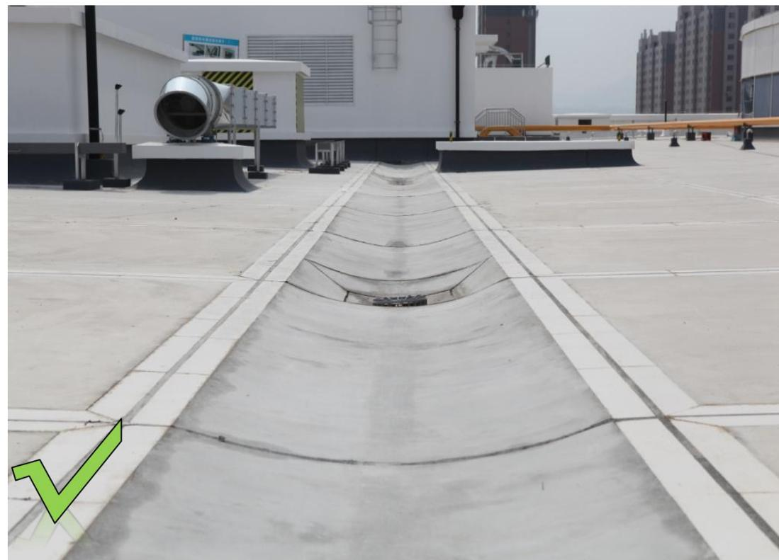
**正确做法：利用BIM深化技术合理设置结构找坡及天沟构造**
