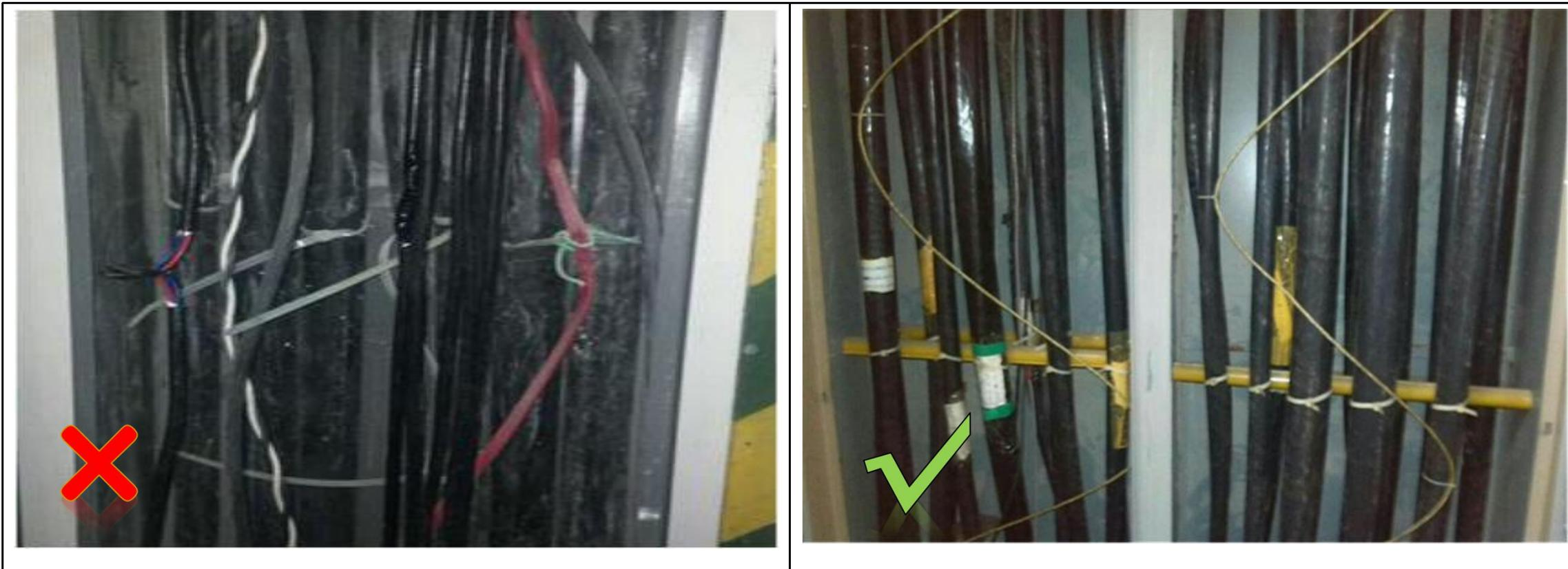
正确做法：感温电缆按正弦波接触式敷设；波峰、波谷间距不超过1.8m；报警信号接入报警主机
