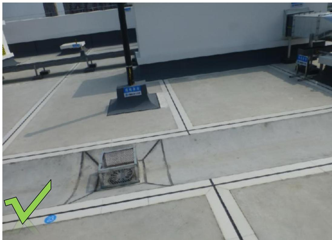
**正确做法：利用BIM技术将排水斗设置在天沟最低点、中间位置**
